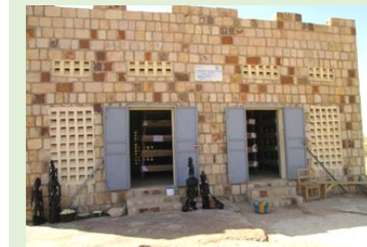
Magasin de stockage vue de l'extérieur
